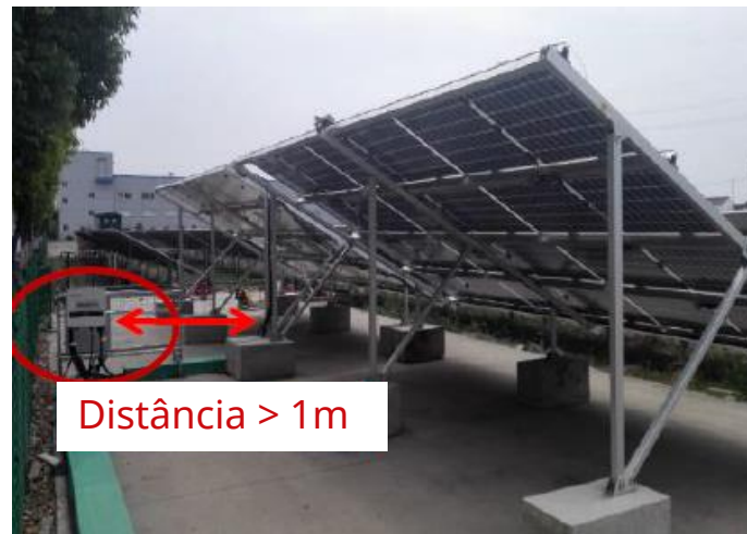
Posicionamento do Inversor em Sistemas Bifaciais
