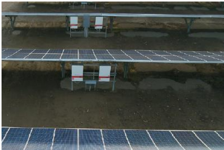
Posicionamento do Inversor em Sistema Monofaciais
